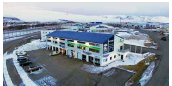
Verkstæði Nesdekkja eru nú sex talsins í Reykjavík, Garðabæ, Reykjanesbæ og á Akureyri. Hér má sjá húsnæði fyrirtækisins á Akureyri.
