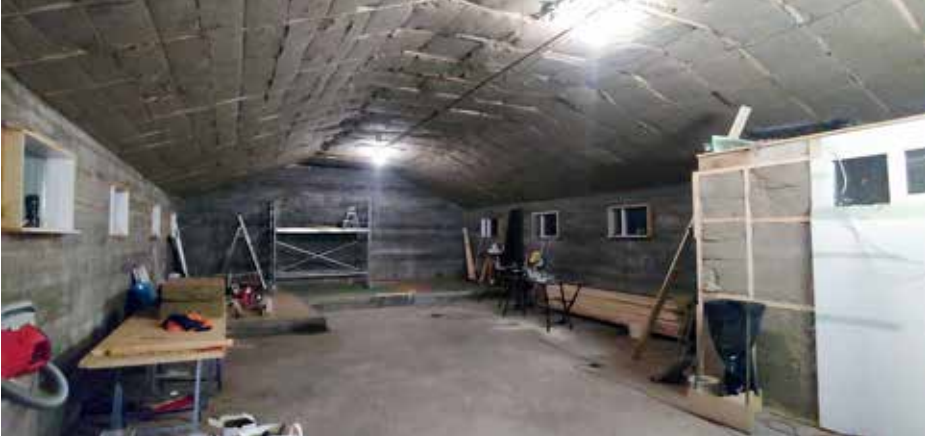
Gömul vélaskemma á Gilhaga var nánast holið að innan, loftið einangrað, klætt og málað, gólf flotað og lagt nýtt vatn og rafmagn í húsið, auk þess sem settir voru upp innveggir sem skipta húsnæðinu í tvo vinnslusali.
