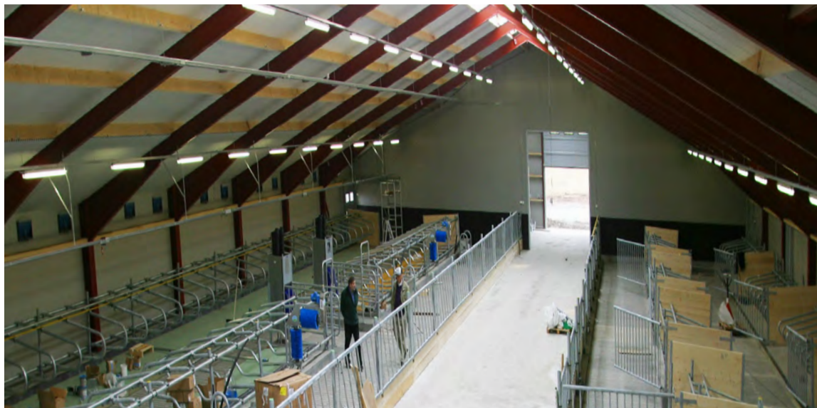
Nútímalegt fjós á lokastigum byggingar.
