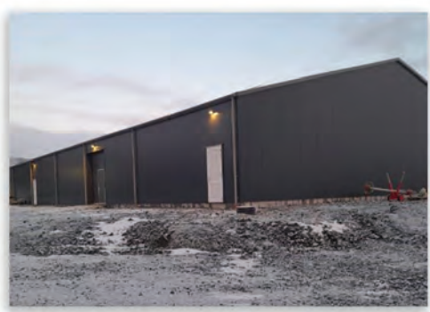
Laxar fiskeldi ehf. Bakka í Ölfusi - Yfirbygging yfir ker - 1.868m 2
