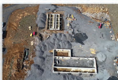
Landsnet hf. - Alverk Njarðvíkurheiði - Tengivirki og spennahús 323m 2 og 235m 2 - "Í vinnslu"
