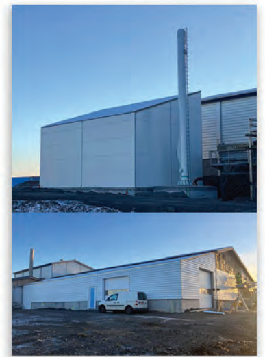
Orkugerðin ehf. Flóahreppi - Viðbygging og nýtt hús fyrir gufuketil - "Í vinnslu"
