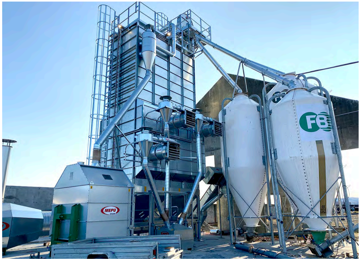
Þurrkarinn tekur um 47 rúmmetra af korni í einu og þurrkar á nokkrum klukkutímum. Hann getur afkastað um 1.500 tonn af þurru byggi á hausti, að sögn Birgis. Myndir / Aðsendar
