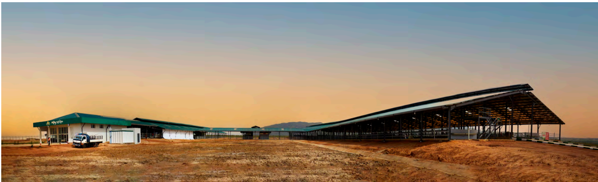
Legubásafjósíð sjálft, hér á hægri hönd, tekur 478 kýr í legubása og er nærri 200 metra langt.
