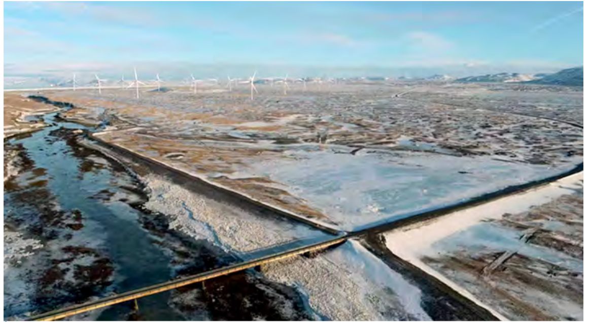
Í Búrfellslundu er gert ráð fyrir allt að 30 vindmyllum, hverri með 4-5 MW uppsett afl og samanlagðri orkugetu um 440 GWst á ári. Landsvirkjun hefur ákveðið að fara í útboð á vindmyllunum.
